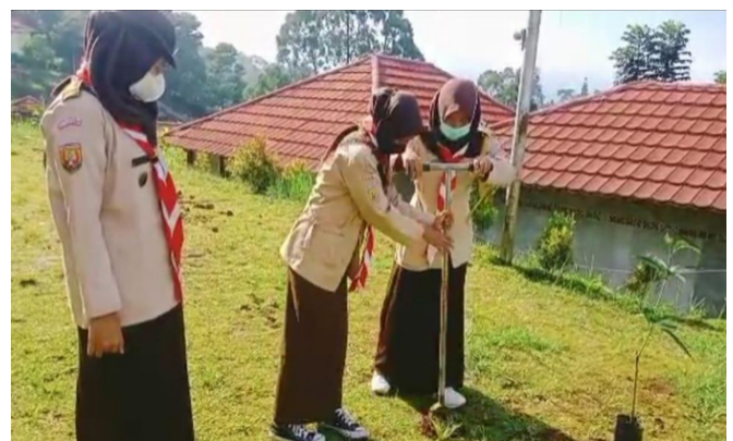
Gambar 5. Pembuatan lubang Biopori/sumur Resapan sedalam 1,5 meter.
