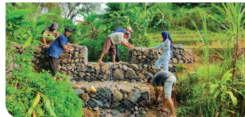
Kegiatan Pembuatan Bangunan Konservasi Tanah dan Air.
